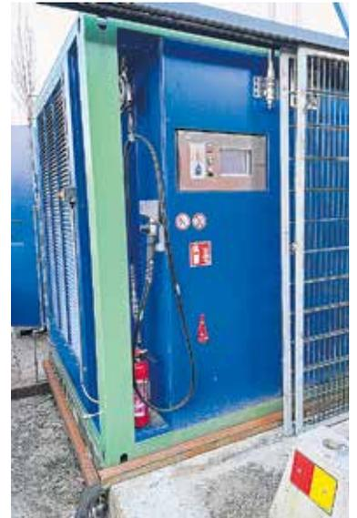
Über eine Gasleitung gelangt der Wasserstoff von der Pilotanlage zur nah gelegenen H<sub>2</sub>-Tankstelle.
