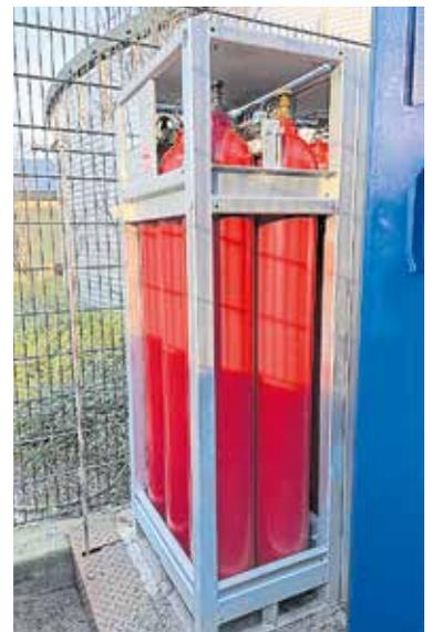
Bereit zum Tanken lagert der Wasserstoff in Gasflaschen. Der Druck in den Flaschen beträgt 300 bar.
